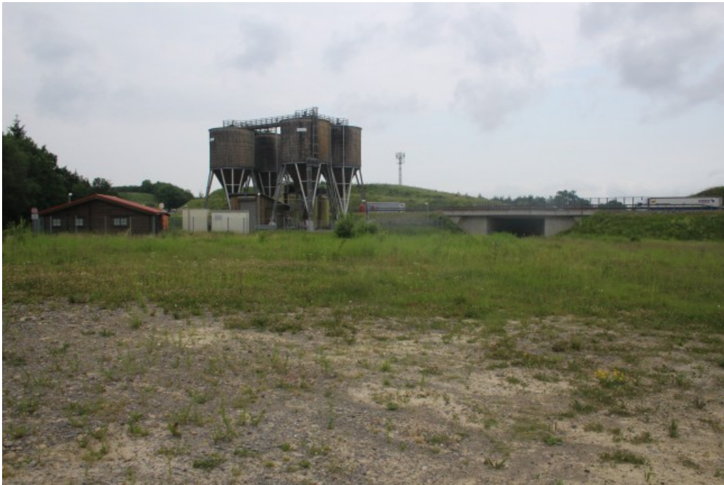
Abbildung 1: Durch Bauarbeiten stark verdichteter Bereich
